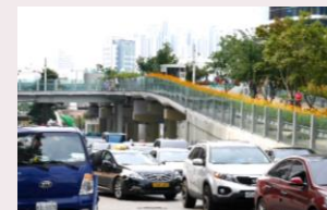
既存の車路スロープを活用 （ソウル）
